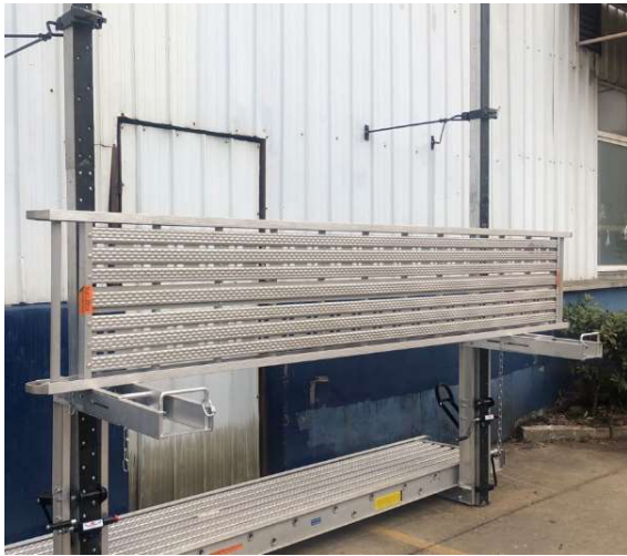
Positionner la passerelle (plank) sur le pump-jack
