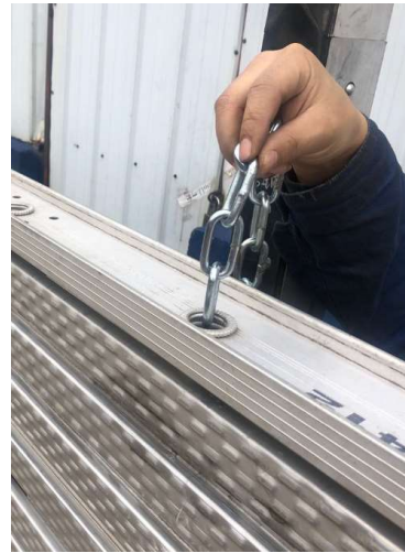
Passer la chaîne dans l'échelon et l'attacher à la tige en aluminium
