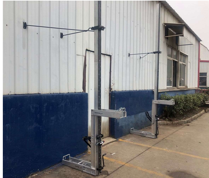
Étape 2 : Assembler le poteau sur le l'encrage et serrer les boulons en T (T-Bolts).
